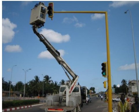
Pose de dispositifs de signalisation lumineuse (Avenue des Evala & Boulevard de la Kara à Lomé)
