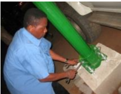
Pose de panneaux de signalisation verticale - Chantier de la rue Amémaka Libla à Lomé
